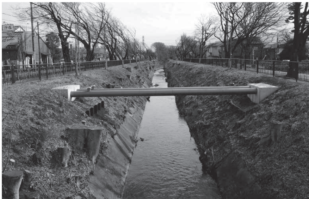
関野橋から皆伐された下流を見る（2016.2.22）
